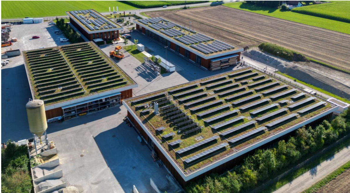
Abbildung 23 Begrünte Dächer der Stadtwerkezentrale Weilheim, Foto Stefan Herbst SW, Stadtwerke Weilheim.
